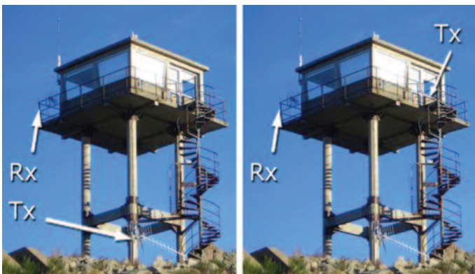
Στη πολύ απλή περίπτωση που δεν θα χρησιμοποιηθεί μεταλλάκτης, η απομόνωση των κεραίων εκπομπής λήψης είναι ο μόνος τρόπος για την προστασία από ανάδραση.
